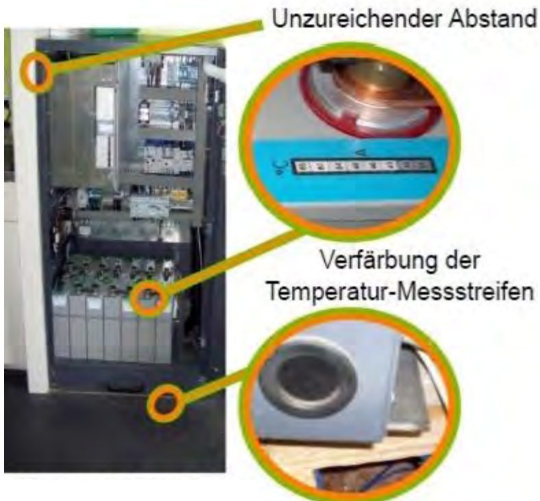
Untersuchung 1. Direkt auf brennbaren Untergrund: Holzfußboden aufgestellt.
