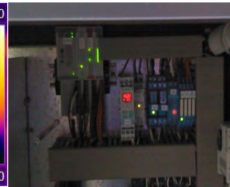
IR und VI eines thermisch auffälligen Installationsschützes von Untersuchung 1.
